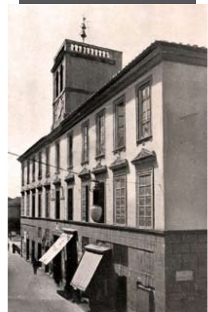
S. M. Capua Vetere, palazzo dei Tribunali, la facciata su via Mazzocchi con l'ottocentesca torretta dell'orologio demolita intorno al 1930 (da Di Giacomo, 1925)
